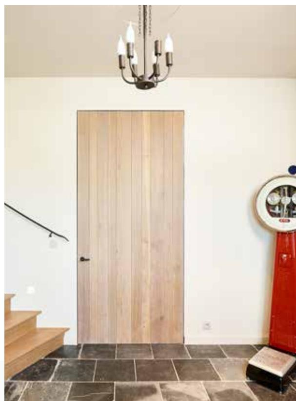
▲ Stalen kassement met onzichtbare scharnieren /
